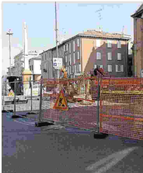
Il cantiere in Piazza Artigiani per riqualificare l'area
